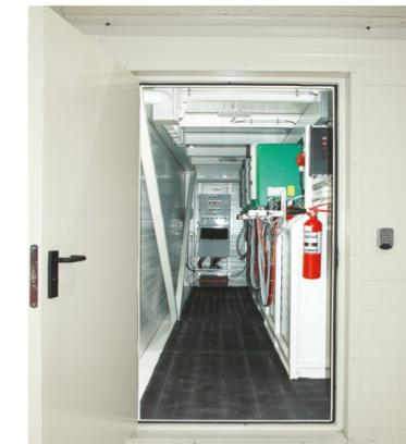
Accesul spre ZONA DE ÎNCĂRCARE A BATERIILOR se face prin deschiderea ușii tip rulou aflată pe lungimea construcției și reprezintă spațiul de introducere/extragere a bateriilor industriale pentru operația de încărcare electrică (zonă destinată utilizatorilor finali).
